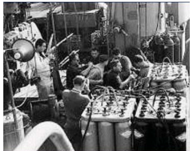
Il ponte della nave-appoggio ingombro di bombole contenenti i gas per la preparazione delle miscele respiratorie.
