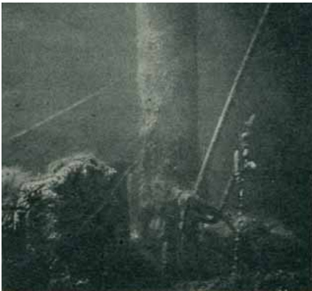
L'ambiente sotto il ponte era veramente inquietante. Sembrava come di essere in una nave affondata.
